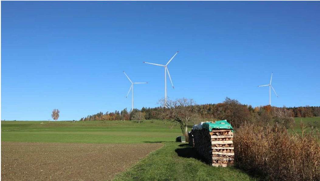
Abbildung 153: Fotomontagen von der Frauenfelderstrasse aus Richtung Norden (2716072/1267556); Nabenhöhe 175 m / Rotordurchmesser 172 m / Gesamthöhe 261 m für Windpark Layout 20. Die neue Verbindungsstrasse verläuft entlang des Ackers im Vordergrund.
